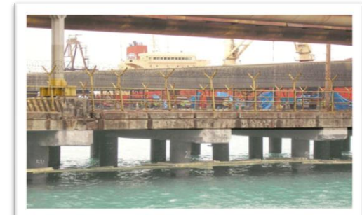
Tiang Pancang Dermaga PT. Krakatau Bandar Samudera 2004
