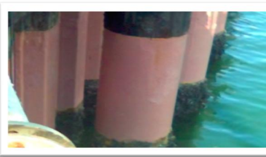
Pipa Tiang Pancang PT. Pupuk kalimantan Timur 2007
