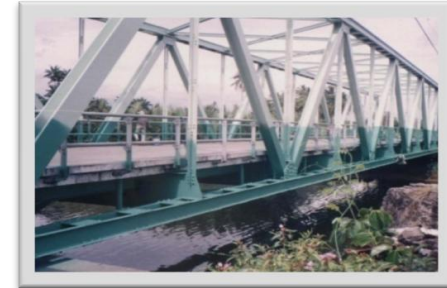
Jembatan Andalas PU Bina Marga - 1999 Epoxy (75 micron) - Polyurethane (75 micron) Simacover EP Unicoat - Simathane Gloss
