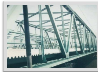
Jembatan Muaro Api - Api PU Bina Marga - 1999 1999 Epoxy (75 micron) - Polyurethane (75 micron) Simacover EP Unicoat - Simathane Gloss
