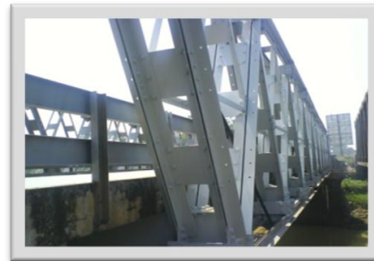
Jembatan Ciasem PU Bina Marga - 2008 Epoxy (75 micron) - Acrylic (50 micron) Simacover EP Unicoat - Simacare Finish
