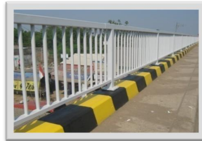
Jembatan Kedung Gede PU Bina Marga - 2009 Epoxy (75 micron) - Acrylic (50 micron) Simacover EP Unicoat - Simacare Finish
