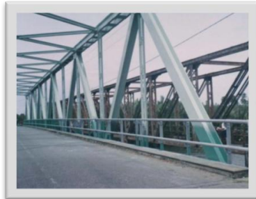
Jembatan Batang Terusan PU Bina Marga - 1999 1999 Epoxy (75 micron) - Polyurethane (75 micron) Simacover EP Unicoat - Simathane Gloss
