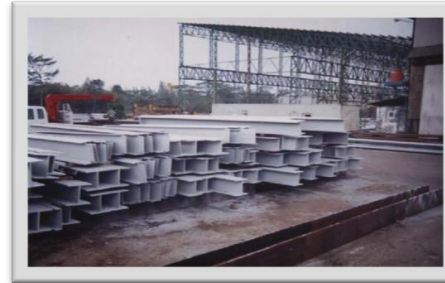
Jembatan Barito PU Bina Marga - 2007 Epoxy (75 micron) - Polyurethane (75 micron) Simacover EP Unicoat - Simathane Gloss
