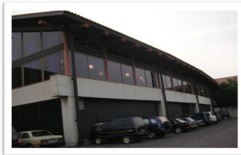
Bandara Soekarno Hatta Lokasi : Banten 2005
