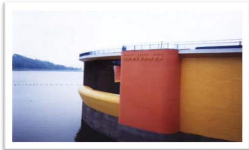
Bendungan Jati Luhur Lokasi : Jawa Barat 2006
